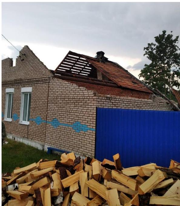
10.06.2020 вследствие порывов ветра до 27 м/с в Бешенковичском районе Витебской области установлены факты повреждения жилого дома в аг. Улла по ул. Первомайская, 88 (разрушена крыша, частично обрушено потолочное перекрытие), а также повреждения 50 м<sup>2</sup> металлической кровли здания зерносклада учреждения образования «Улльский государственный профессиональный лицей сельскохозяйственного производства им. Л.М. Доватора» в аг. Улла по ул. Корневского, 18.
