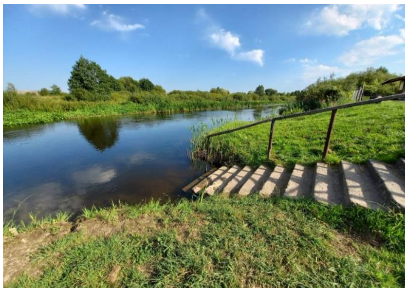
Рисунок 6.21 – Забетонированный сход в реку на КУ Бакшты р. Западная Березина
